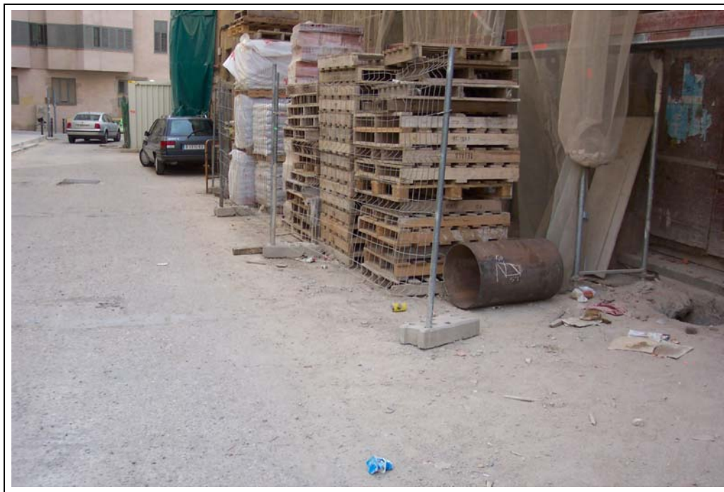
Foto 1: Vista general de la zona prèvia a la intervenció
