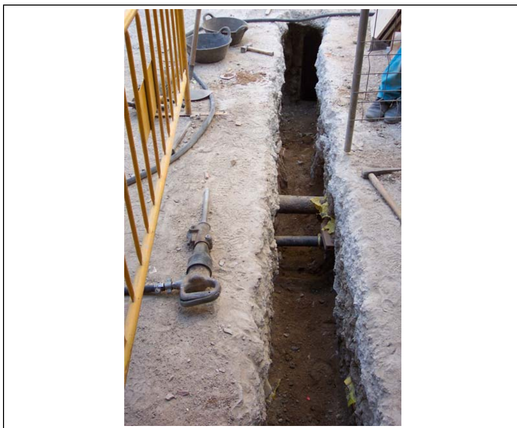
Foto 8: Excavació del tram de la façana de l'immoble després de l'eliminació dels murs UE 102 i 103
