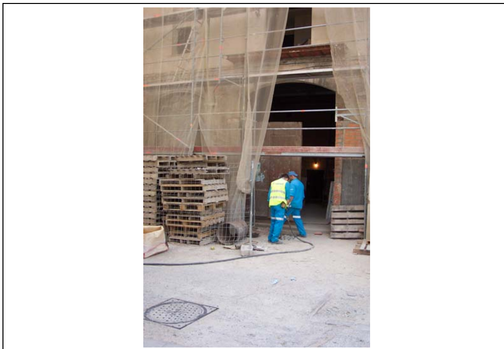
Foto 2: Inici dels treballs d'obertura de la rasa
